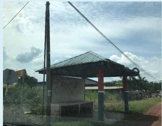
Foto: Keadaan Semasa Pondok Bas Kampung Parit Tengah Sumber: Kajian Hala Tuju Strategik Desa Johor
