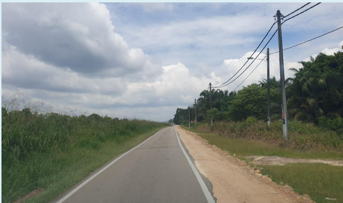
Foto: Keadaan Semasa Jalan Perhubungan Ke Kampung Parit Sagil Sumber: Kajian Hala Tuju Strategik Desa Johor
