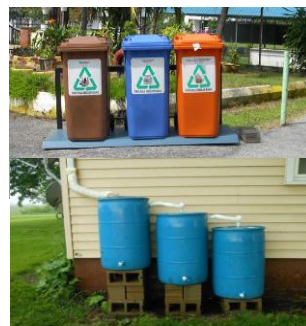
Foto: Tong 3R dan Pemasangan Sistem Penuaian Air Hujan (SPAH)
